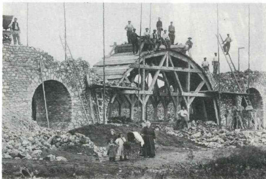
Construction du pont de chemin de fer à Cergy en 1909
